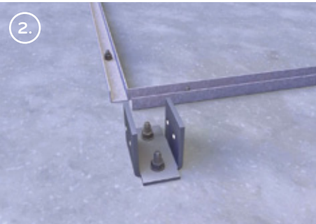
Fixer les profils U sur la dalle
